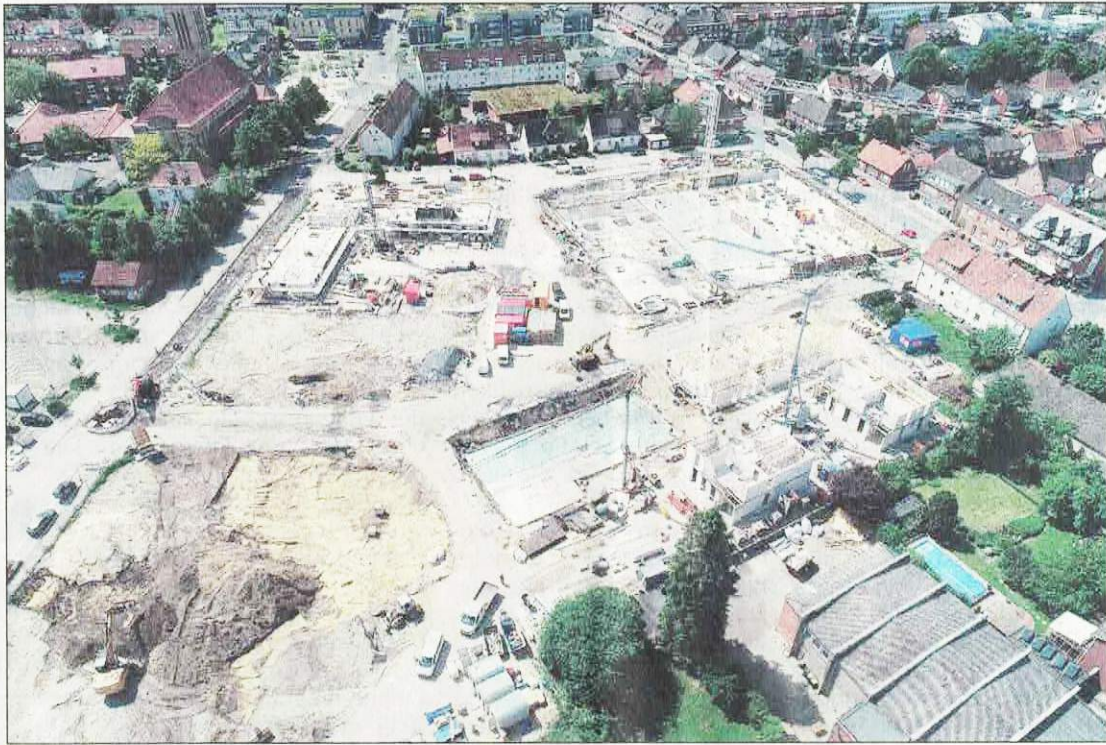
Das Bild zeigt das Baufeld.
