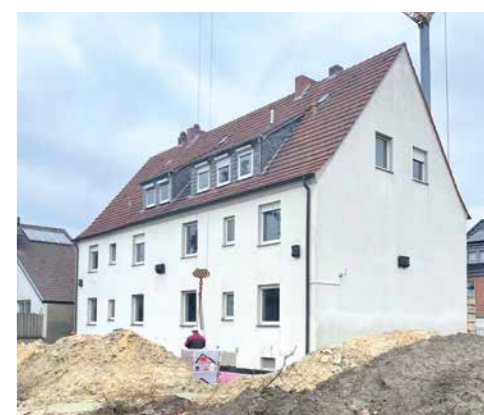
Parkstraße vor Sanierung
