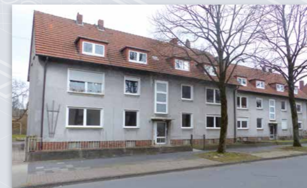
Hauenhorster Straße 11-13 vor Modernisierung
