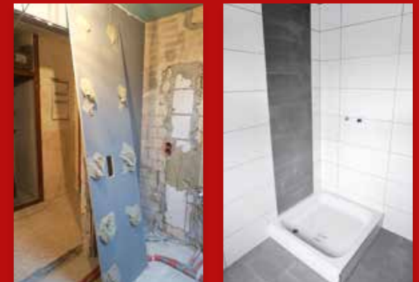
Oststraße 16 – Dusche vorher/naher
