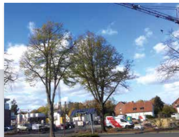
Baufeld Breite Straße
